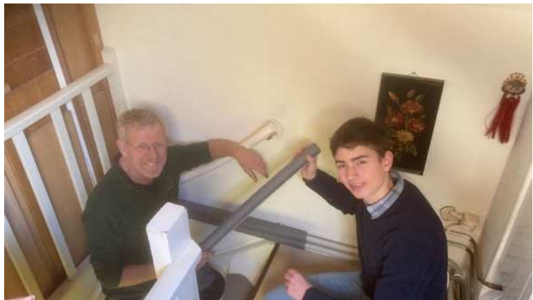
Buisisolatie plaatsen met energieklasser Joop Jabroer op de Schout Beyhartsstraat.
