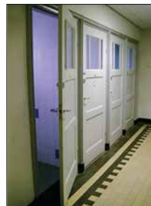
Deuren met oorspronkelijk beslag en tegelvloer
